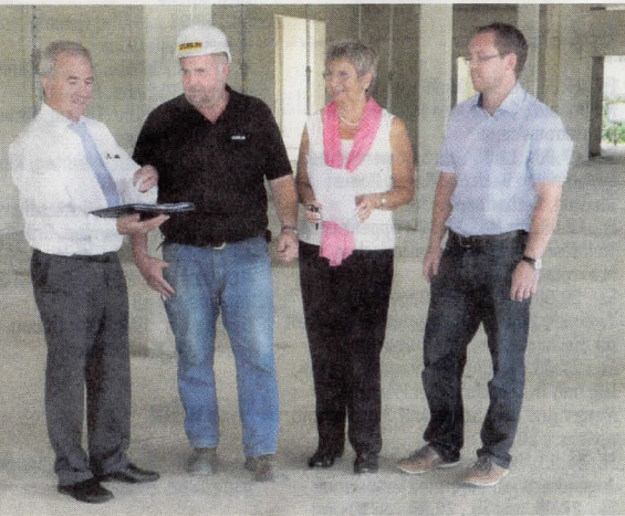
Landrat Claus Schick, Polier Alban Hoffmann, Schulleiterin Helga Lerch und Steffen Wolf von der Schulabteilung des Kreises (v. li.) in der entstehenden neuen „Mensa“ des Nackenheimer Gymnasiums Foto: Margit Dörr
